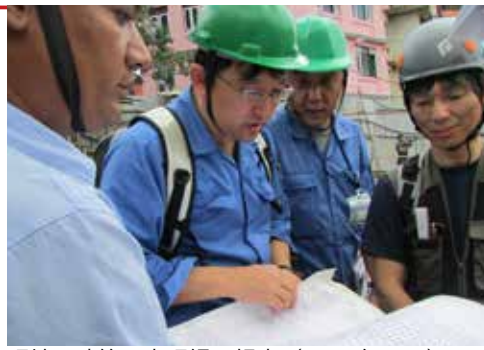
現地の建築工事現場の視察（2016年6月）
